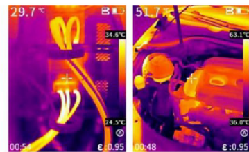
Mantenimiento de instalaciones de aplicaciones eléctricas.
